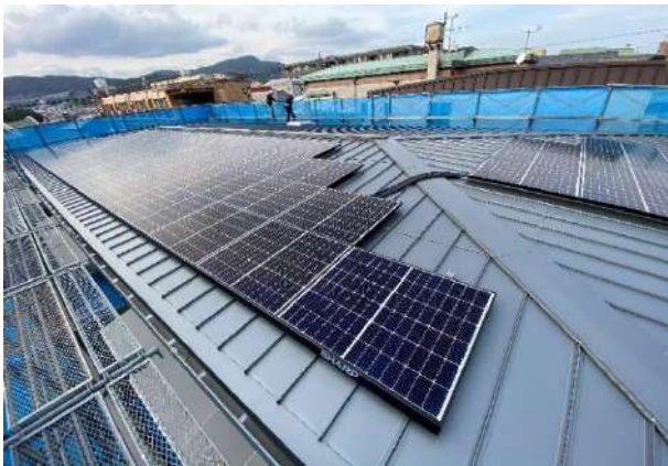
太陽光発電システム（施工時撮影）
